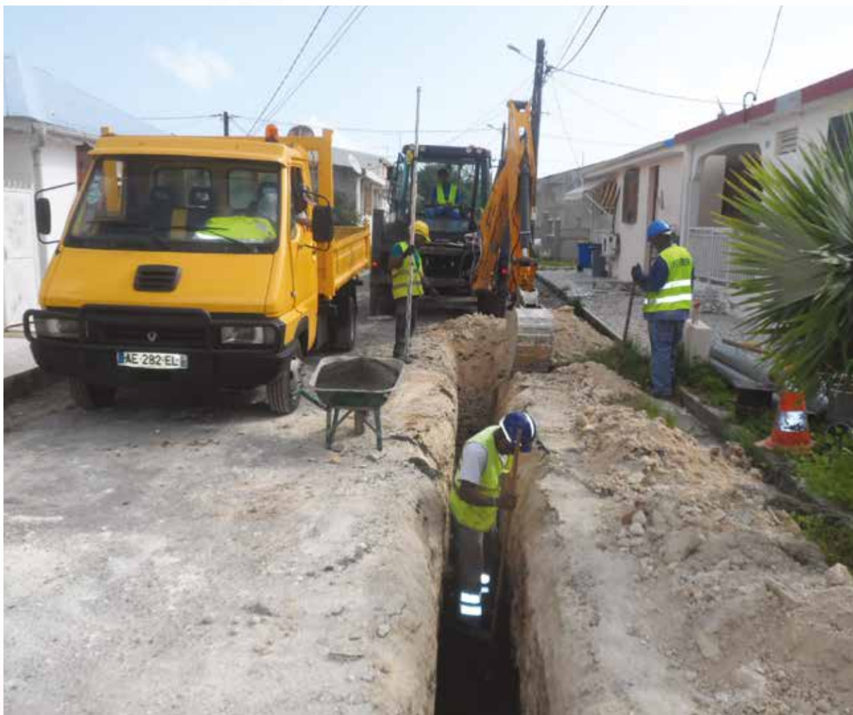
Figure 26 : Pose d'un réseau de collecte d'eaux usées (source : Office de l'Eau)
