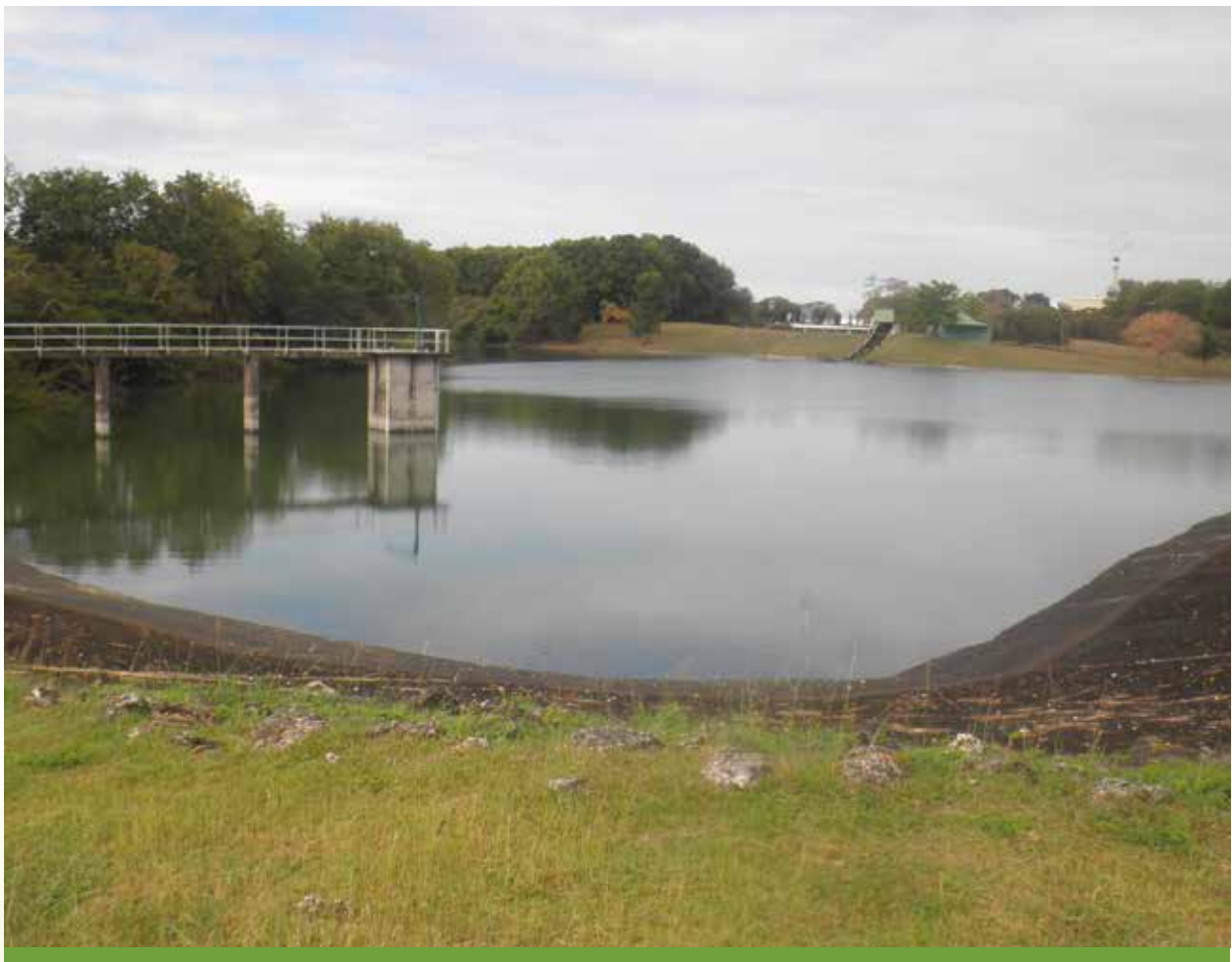
Figure 11 : Barrage de Letaye (source : Office de l'Eau)
